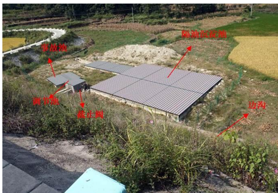
图 6.3-3 某公路径流收集系统典型照片
